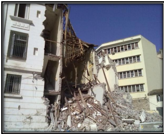
Photo N° 11 : L'ex-tribunal de Bejaia s'effondre le 08 Mars 2011
