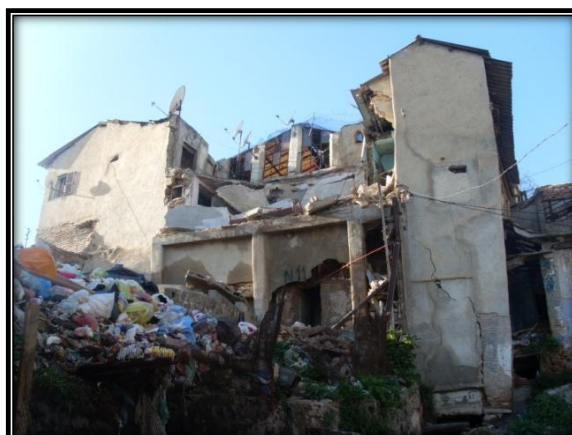
Photo N° 16 : Des habitations en risque d'effondrement (Souika)
