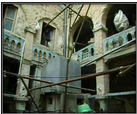
Photo N° 17: Une bâtisse en cours de réhabilitation (Avril 2009)
