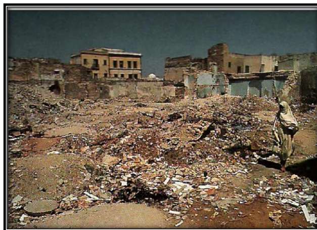
Photo N° 02 : Quartier ancien en ruine (Hafsia, Tunisie)
